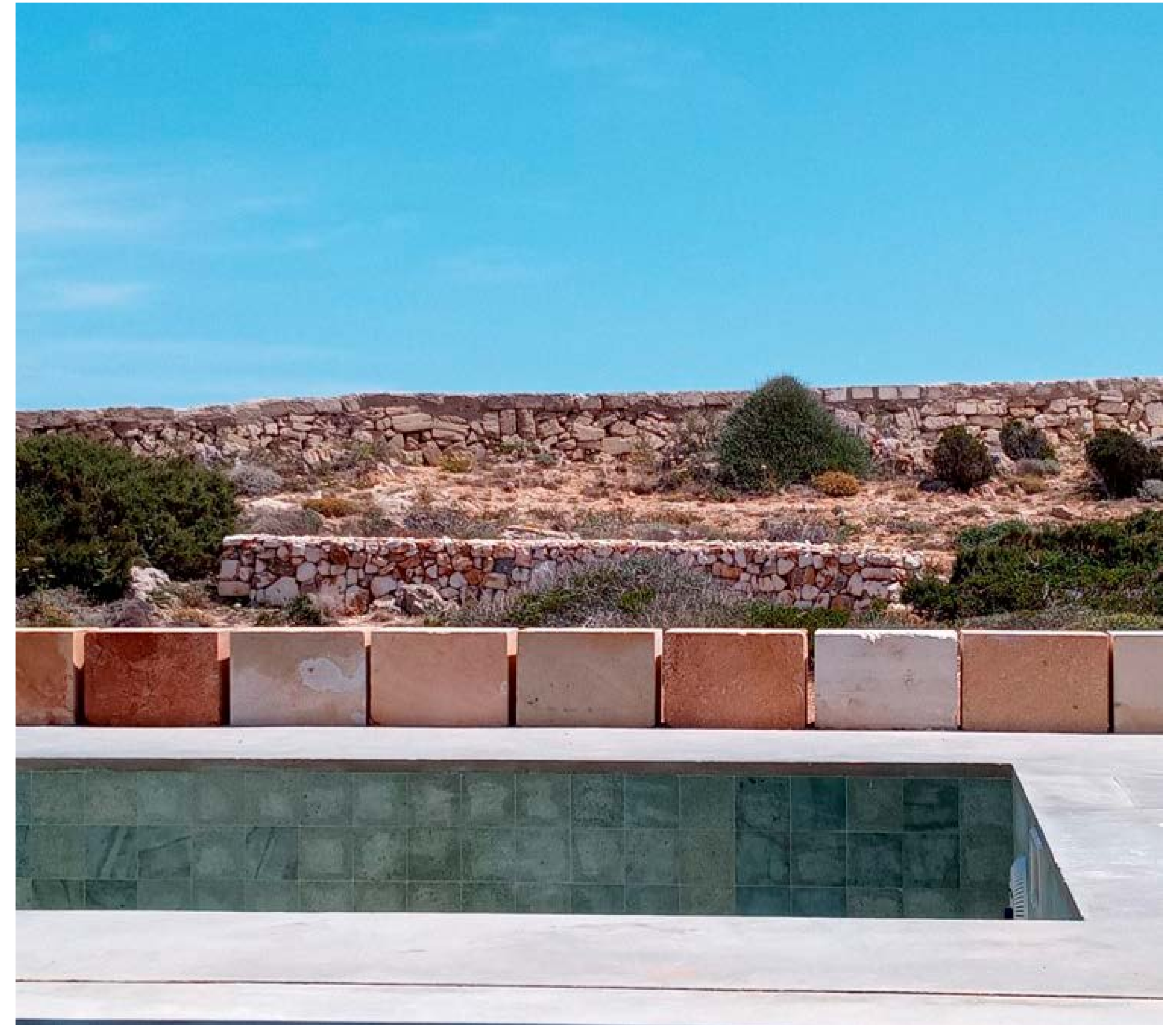
Detalles de vivienda CP37: muros exteriores | Malu de Miguel
