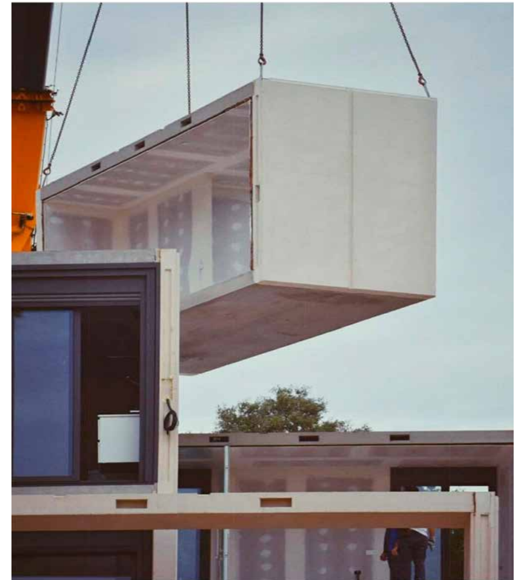
Viviendas | Equip XCL
