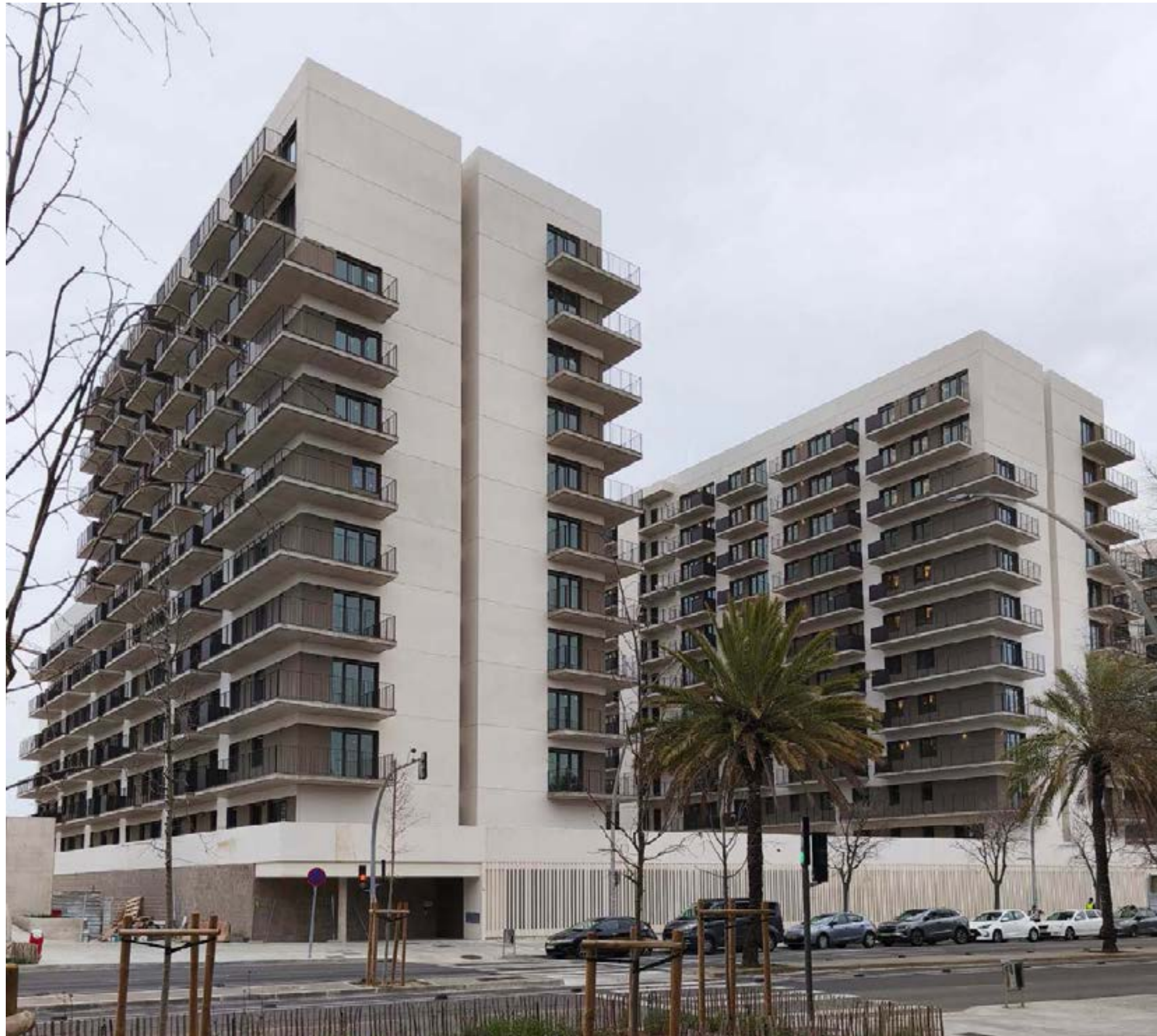
Transformación de la fábrica AEG | GCA Architects
